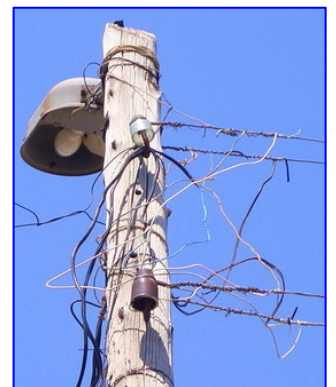
Опора на одном из объектов после которой счётчики оказались невидимыми для концентратора.
